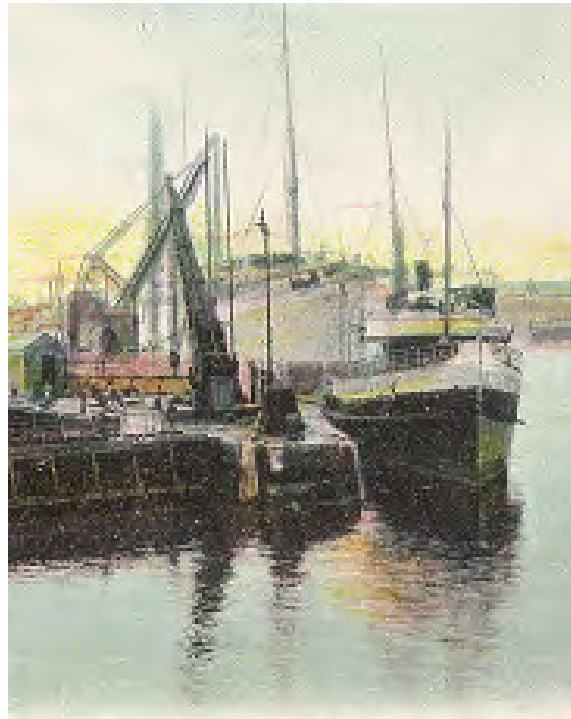
Kran am Trockendock in Bremerhaven 1906
